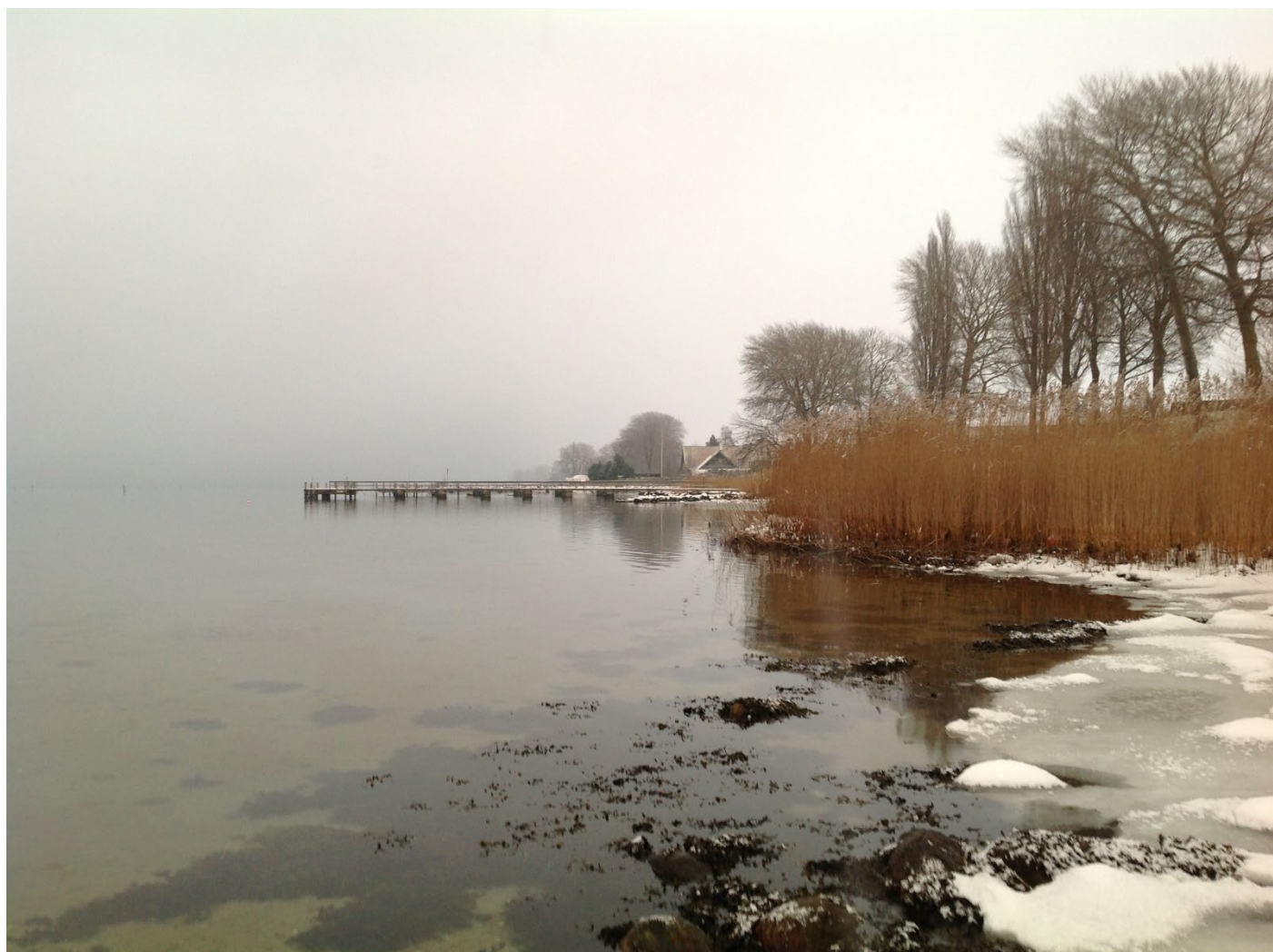
Foto fra Ø-side - ingen kystbeskyttelse og ingen erosion
